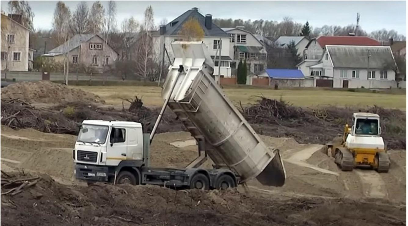
Для борьбы с паводком там сейчас активно идет строительство дамбы, которая будет длиной 4 километра и 8 метров в высоту. В строительстве потребуется более 700 тысяч тонн песка. Завершить работы планируется к началу 2026-го.
