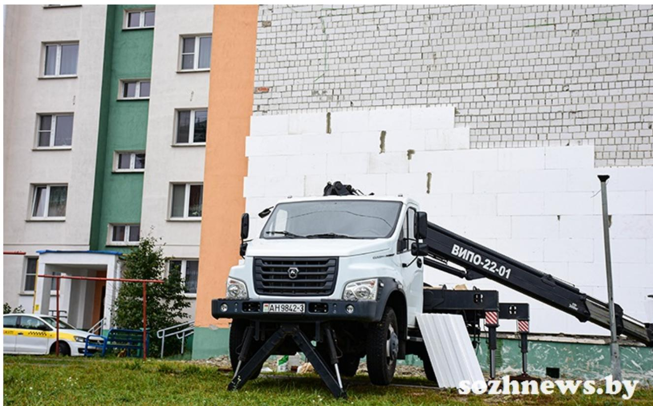
После урагана было проведено дополнительное отслоение и удаление аварийных участков утеплителя. С одной из проектных организаций областного центра осуществлен подбор нового материала с большим запасом прочности для утепления стены дома.
