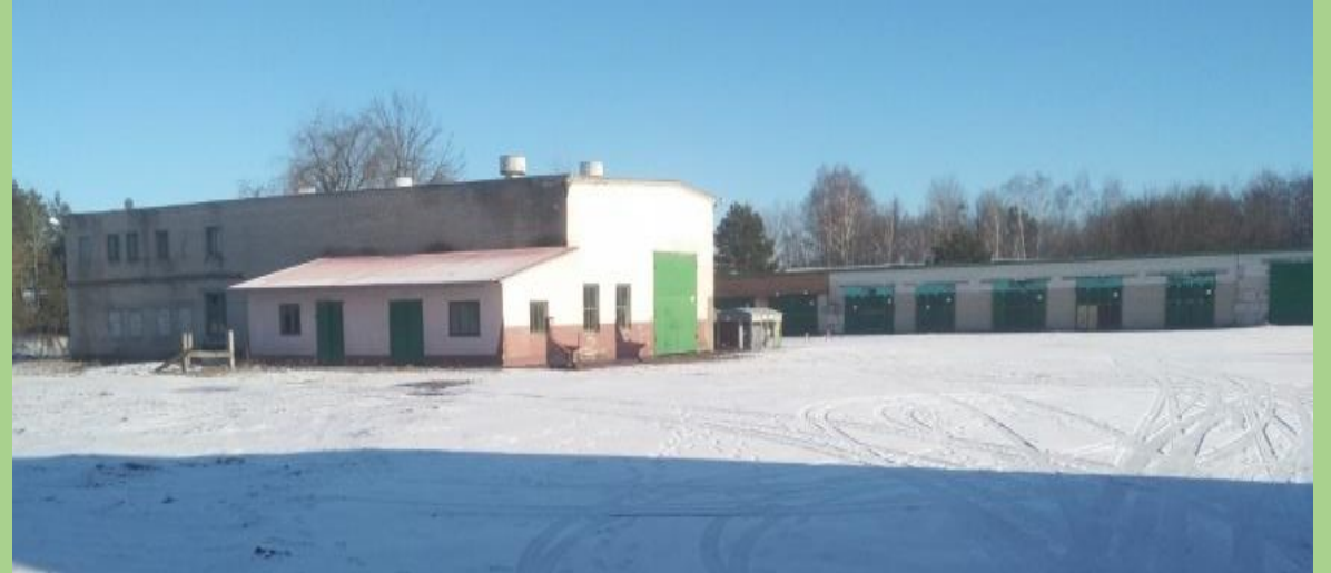
Здания ремонтно-мастерских автогаража н.п. Шарпиловка
