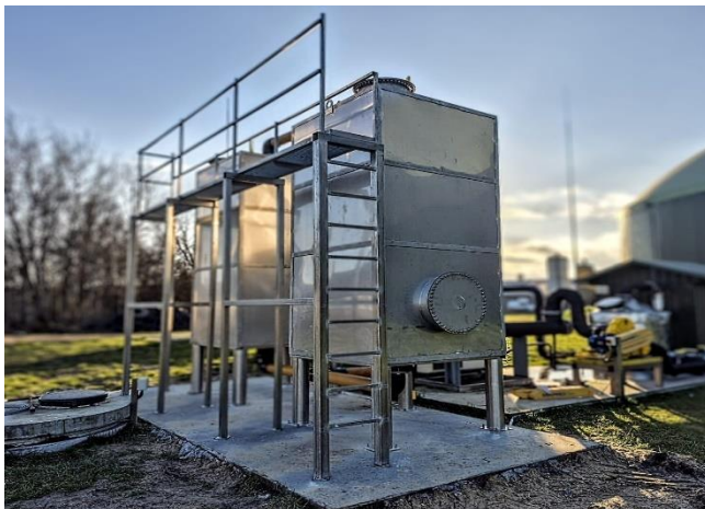
Рисунок 3.2.1.3. Фильтр биогаза, КГУ Jenbacher J320 (объект-аналог)
